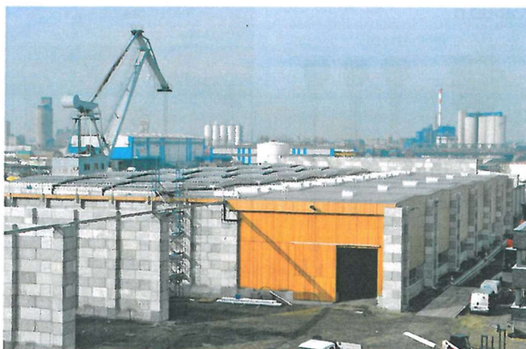
► Vue du nouvel entrepôt de M. ZIETZSCHMANN dans la zone portuaire de Neuss / View of the new warehouse of M. ZIETZSCHMANN in the Neuss port area (doc. Toit Découvrable).
